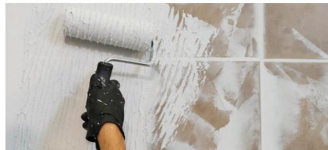
Nach der Trocknung des Flächenspachtels das Material mit dem Spezialroller satt aufrollen, sodass die Fläche vollständig mit dem Flächenspachtel bedeckt ist. Arbeiten Sie in Teilflächen und „nass in nass“, um Ansätze zu vermeiden. Glätten Sie die Fläche mit einer Venezianischen Glättkelle. Lassen Sie die Fläche anschließend mindestens 24 Stunden trocknen. Nach der Trocknung die Oberfläche mit einem feinen Schleifpapier (120er Körnung) schleifen.
