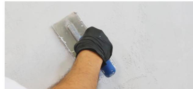
Mit der Glättkelle den Flächenspachtel unter leichtem Druck und flachem Winkel abziehen, sodass eine betontypische Oberfläche entsteht. Je mehr Sie drücken, desto glatter die Oberfläche.
