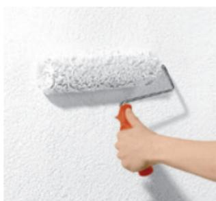
Ist der Zwischenanstrich getrocknet, können Sie in gleicher Weise mit dem Schlussanstrich beginnen. Berücksichtigen Sie je nach Temperatur und Luftfeuchtigkeit Trocknungszeiten zwischen 6 und 24 Stunden. Der vollständige Fassadenanstrich ist nach 2 bis 3 Tagen durchgetrocknet und belastbar.
