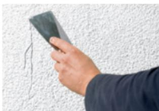
Lösen Sie lockere Putzteile mit einem Spachtel, kratzen und bürsten Sie Risse gut aus. Diese Stellen müssen nach der Grundierung ausgebessert werden.
