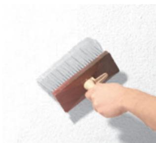
Tragen Sie die Grundierung mit einer Deckenbürste gleichmäßig und satt auf die gesamte Fläche auf. Bereiche, die Sie nicht streichen wollen, bitte sorgfältig abdecken! Die grundierte Fläche muss über Nacht trocknen, bevor Sie mit dem Zwischenanstrich beginnen können.
