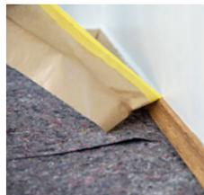
Entfernen Sie die Klebänder, solange die Farbe noch nass ist. So entstehen saubere Kanten und Übergänge zu den Fußleisten etc.
