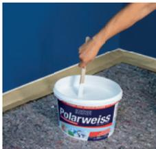
Die Farbe mit einem Rührholz gut durchrühren, damit sie homogen ist und alle Pigmente gleichmäßig verteilt werden. So vermeiden Sie spätere Schlieren und unschöne Flecken auf der Wand.
