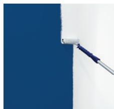
Legen Sie ausreichend Farbe auf und arbeiten Sie im Kreuzgang. Die gestrichenen Teilbereiche noch im feuchten Zustand drucklos von oben nach unten abrollen, damit Ansätze vermieden werden und Sie ein perfektes Oberflächenbild erhalten. Achten Sie darauf, dass Sie immer „nass in nass“ arbeiten, um Ansätze zu vermeiden.
