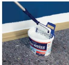
Die Farbrolle gut einarbeiten und ein Abstreifgitter nutzen, um überschüssiges Material abzustreifen. Die Rolle ist sehr gut eingearbeitet, wenn sie beim Rollen auf der Wand „schmatzt“. Beginnt die Rolle nach einigen gestrichenen Bahnen zu „knistern“, ist zu wenig Farbe in der Rolle. Streichen Sie nun die ersten 2–3 Bahnen.
