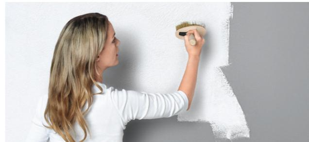
Strukturieren Sie direkt im Anschluss die frisch aufgetragene Strukturfarbe mit der Strukturbürste kreuz und quer. Wenn Sie die Arbeit zu zweit durchführen, können Sie parallel arbeiten, sodass unmittelbar nach dem Materialauftrag die Strukturierung erfolgen kann. Achten Sie beim Anlegen der folgenden Teilflächen darauf, dass Sie immer in die zuvor strukturierte Fläche hineinrollen und strukturieren, um Ansätze zu vermeiden (nass in Nass).
